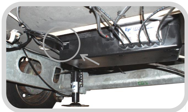
Capot de protection de la pompe électrique avec ses liaisons vers la pompe de secours.
